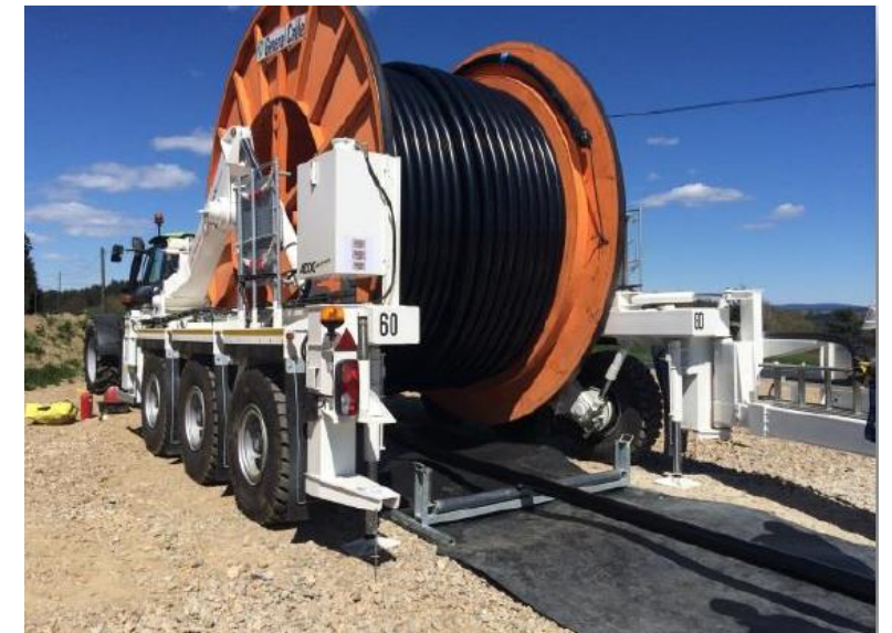
Déroulage du câble
