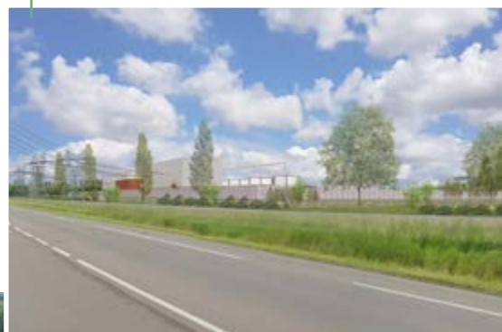
Vue architecturale du poste Noroit
