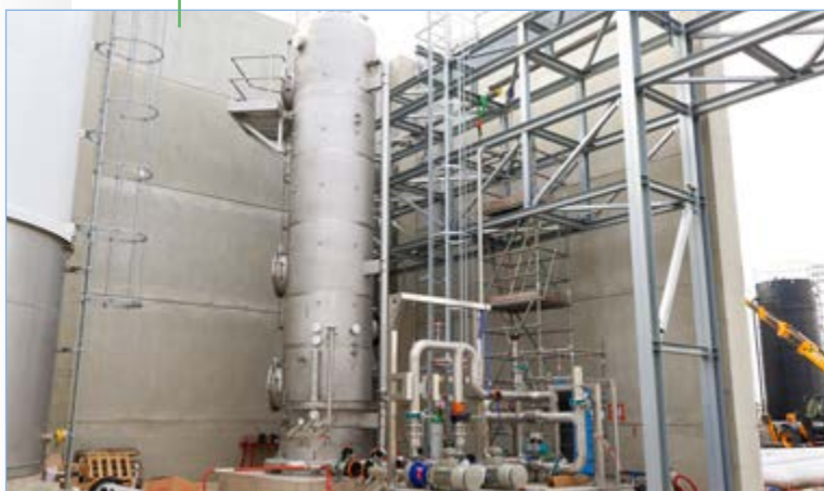
Colonne de lavage (ou scrubber H_2 ) permettant l'élimination des dernières impuretés dans l'hydrogène à l'état gazeux
