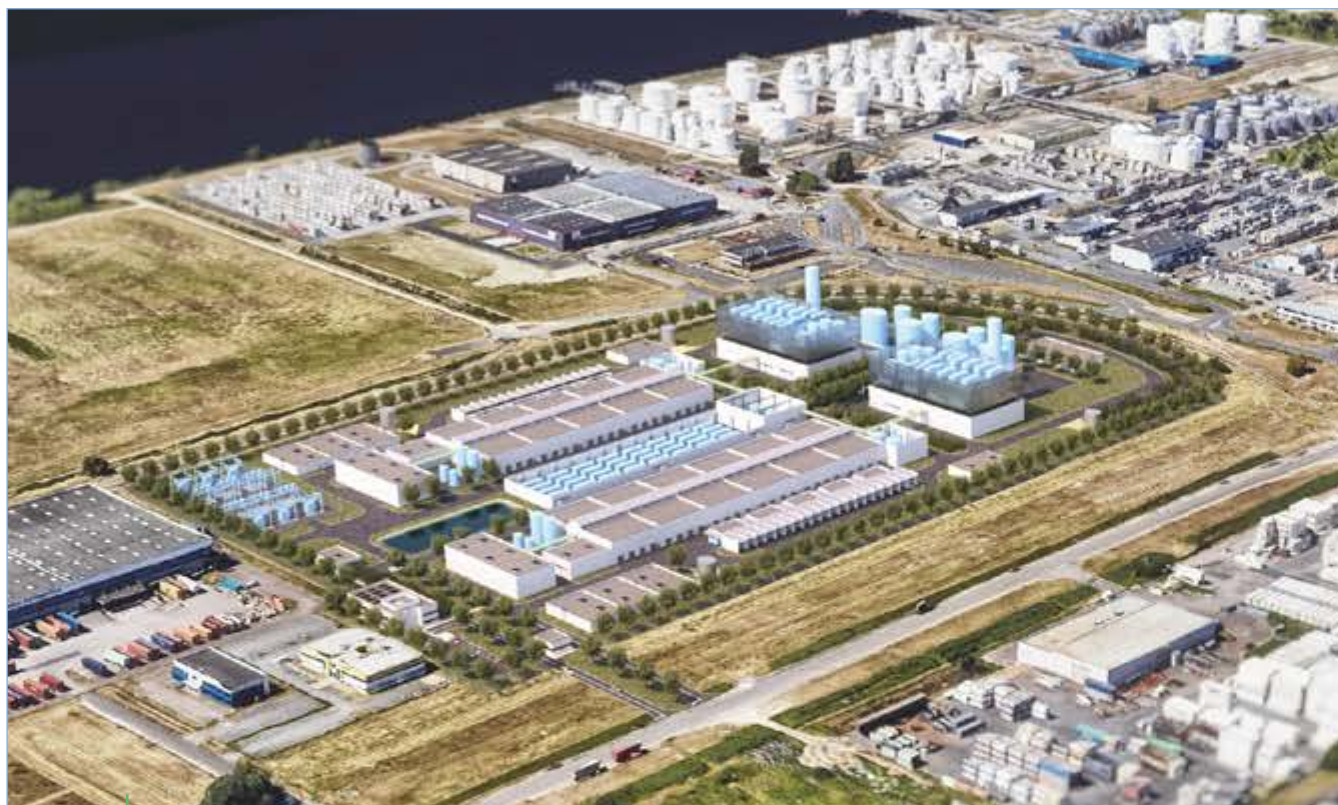
Figure 11. Illustration générique d'usine de e-méthanol (Copyright : MEGIAS-VERNHES Architectes)
